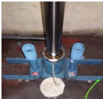
شکل ۳-۹۱ همبندی جک آسانسور هیدرولیکی
