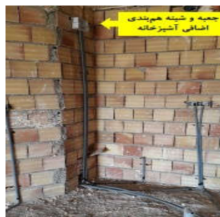
شکل ۳-۷۸) نصب شینه همبندی اضافی در آشپزخانه
