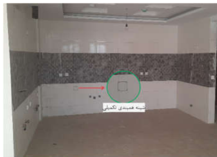
شکل ۳-۷۷) تصویر یک آشپزخانه با ترمینال همبندی تکمیلی
