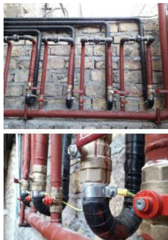
شکل ۳-۸۷) همبندی لوله گاز
