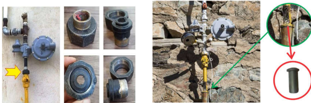
شکل ۳-۸۵) محل عایق شدن علمک گاز در ورود به تأسیسات توسط قطعه‌ای به نام ضربه گیر یا غلاف
